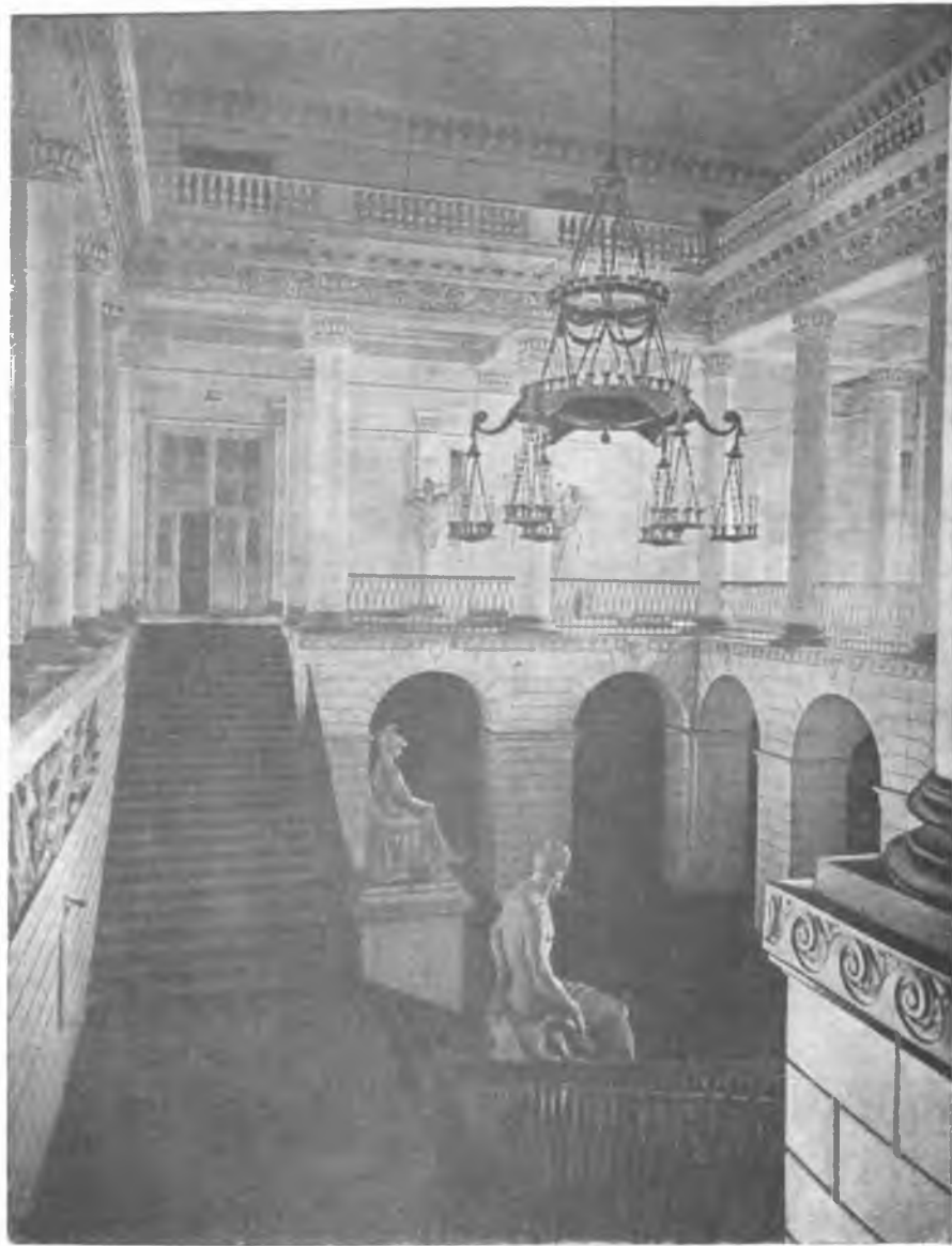
Общий вид Главного вестибюля
