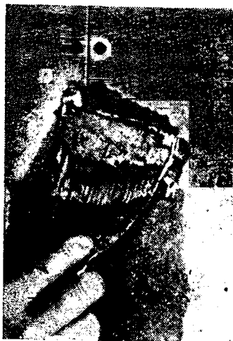
Рис. 91. Заделка шва между плитками сухой штукатурки
