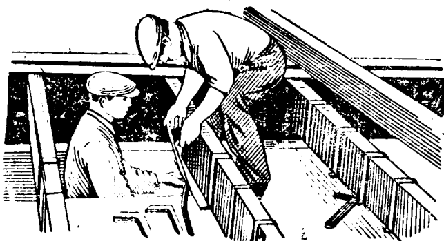
Рис. 80. Монтаж потолков
