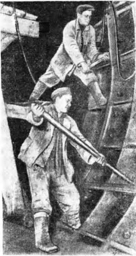
Монтаж чугунных тюбингов на строительстве станции «Бауманская». На снимке — один из лучших стахановцев стройки орденоносец Пётр Ратников и его напарник А. Степкин.
