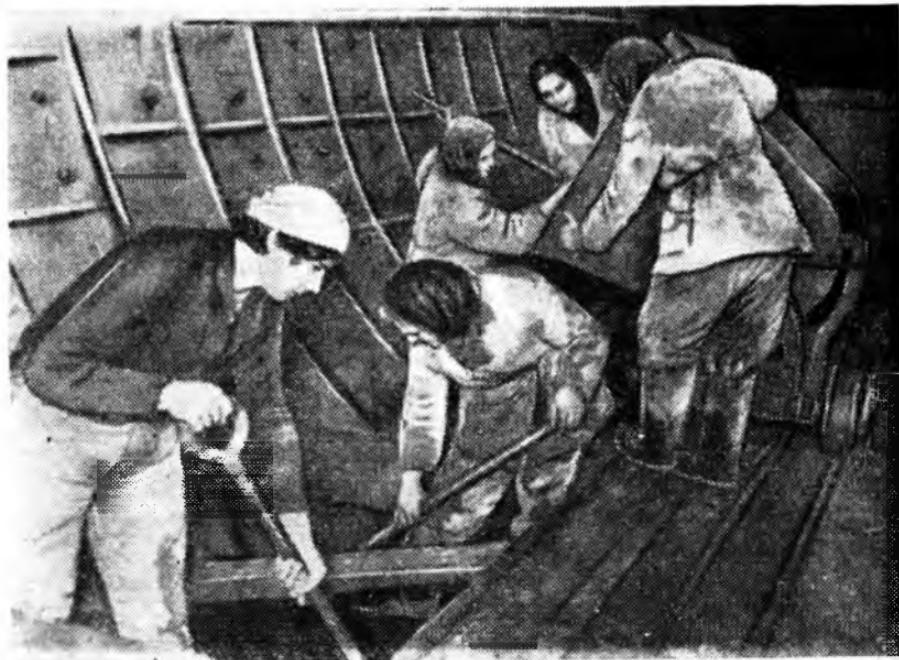
Заливка основания тоннеля бетоном перед укладкой железнодорожного пути на станции «Электрозаводская».
