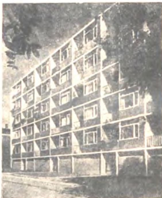
Рис. 24. Жилой дом в Шарлоттенлунде близ Копенгагена
