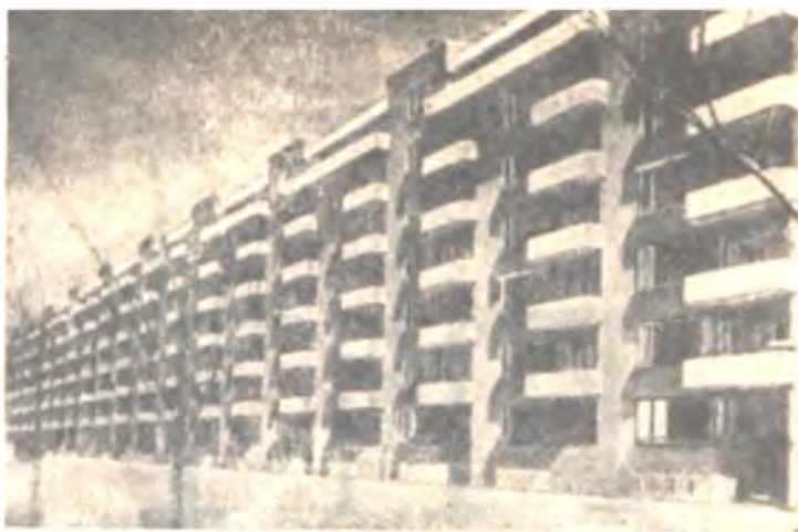
Рис. 23. Жилые дома в Копенгагене. Характерное обилие балконов подчеркивается контрастной отделкой балкона на фоне стены
