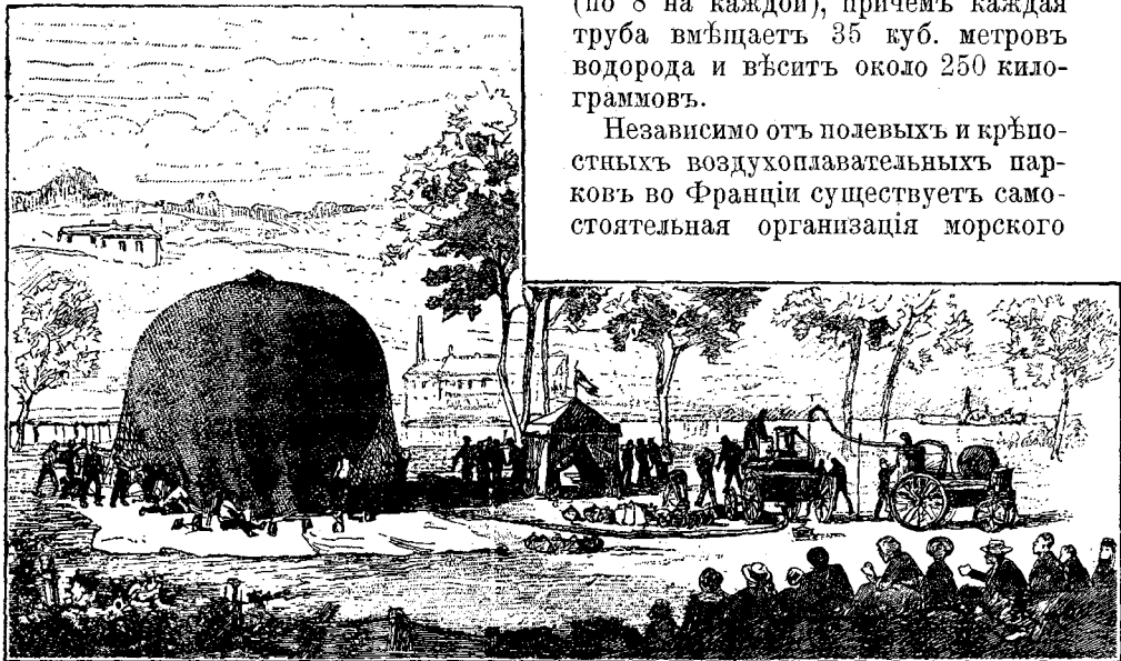
Рис. 95. Способъ наполненія шара при помощи генератора системы Ренара.
