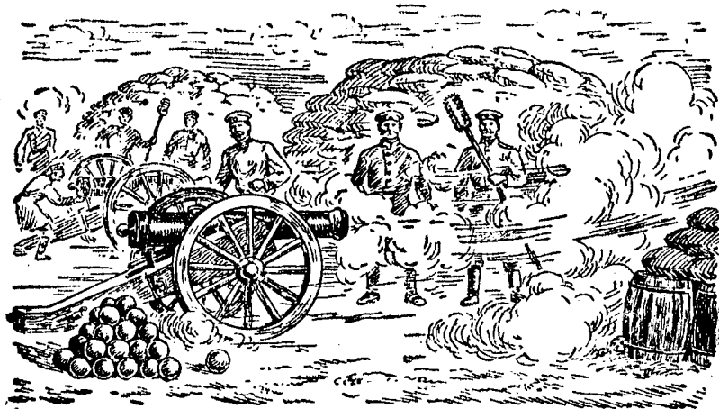
Рис. 59. Откат старых орудий (без противооткатных устройств).
