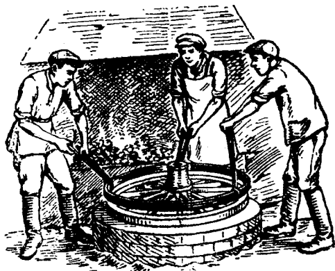
Рис. 91. Как надевают шину на колесо.
