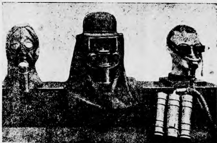
Фиг. 7. Фильтрующие противогазы 1880—1881 гг. (выставка „Gas und Wasser“ в Берлине в 1929 г.).
