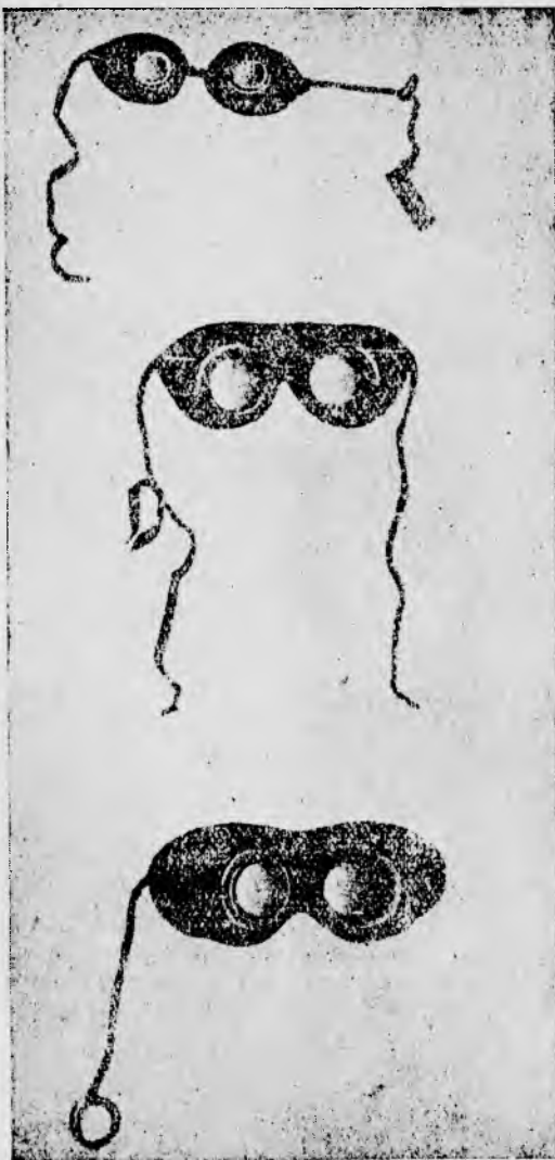
Фиг. 20. Различные виды очков, прилагающихся к влажным маскам и к первым образцам противогаза Горного института.
