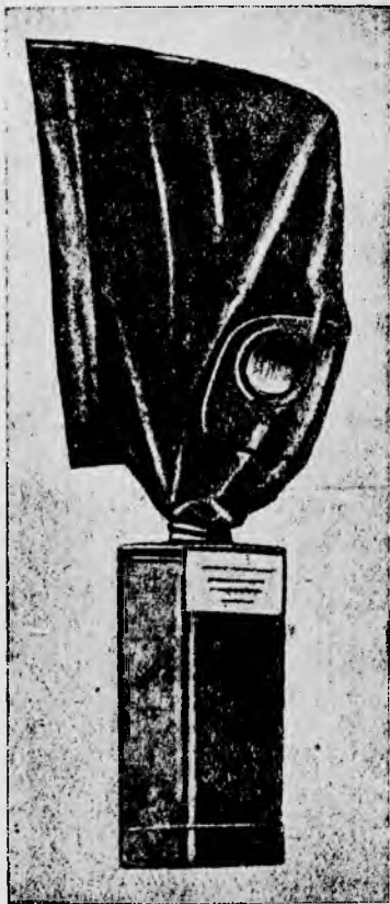
Фиг. 33. Общий вид противогаза Зелинского — Кумманта первых образцов.
