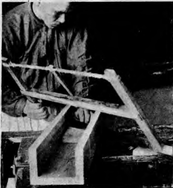
Рис. 129. Пиленіе лучковой пилой подъ угломъ въ стуслѣ.
