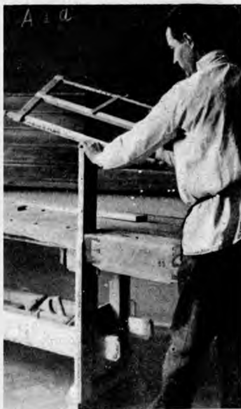
Рис. 130. Правильное положеніе работающаго при пиленіи лучковой пилой короткаго бруска вдоль волоконъ.
