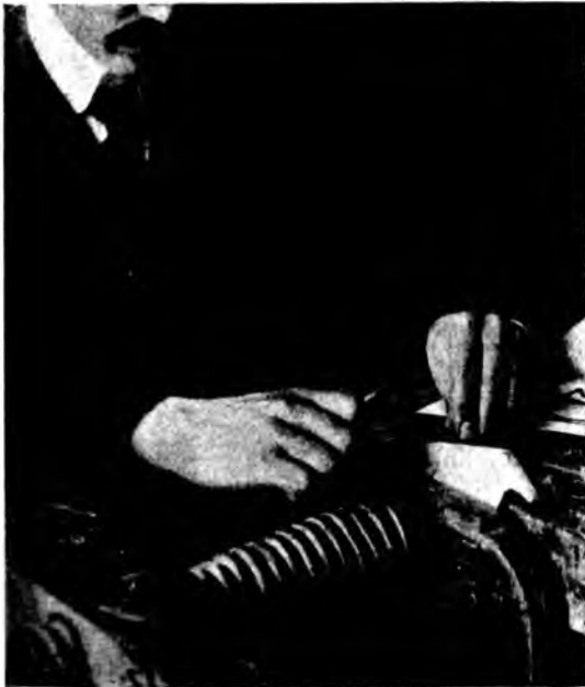
Рис. 172. Отдѣлка сороки подпилкомъ вдоль кромки.
