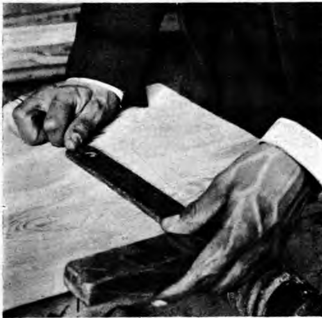
Рис. 88. Проверка угольника. (Угольник перевернуть обратной стороной.)
