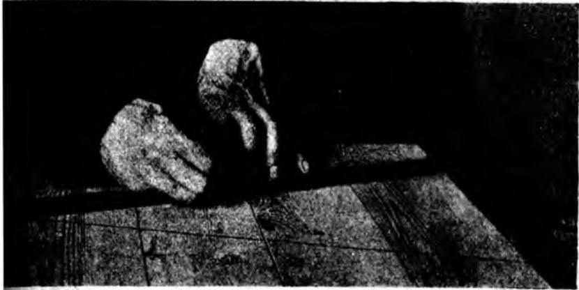
Рис. 144. Обчерчиваніе нѣсколькихъ досокъ при фуговкѣ.
