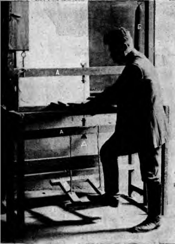
Рис. 105. Выпильной станокъ.
