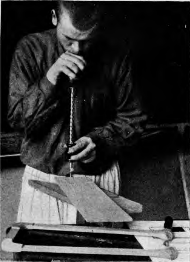
Рис. 216. Просверливаніе дрелью дыръ ( a ) для выпловки внутреннихъ отверстій въ коношнѣ.
