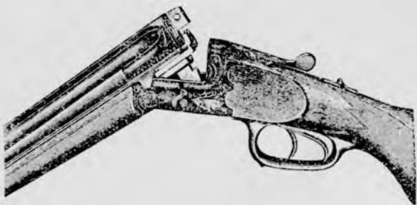
Рис 66. Двустволка с болтом Гринера.
