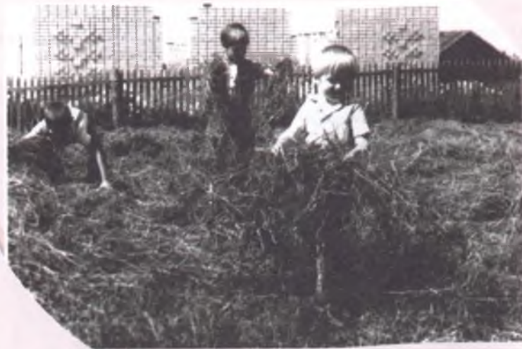
Уборка травы возле строящегося здания детского сада
