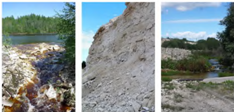
Фрагменты Новомариинского и подводящего каналов, пробитые в толще известняка в районе Александровского
