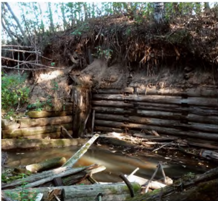
Деревянные конструкции шлюза № 29 у деревни Павшозеро
