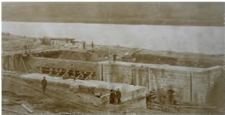
Строительство каменных шлюзов на Шексне
