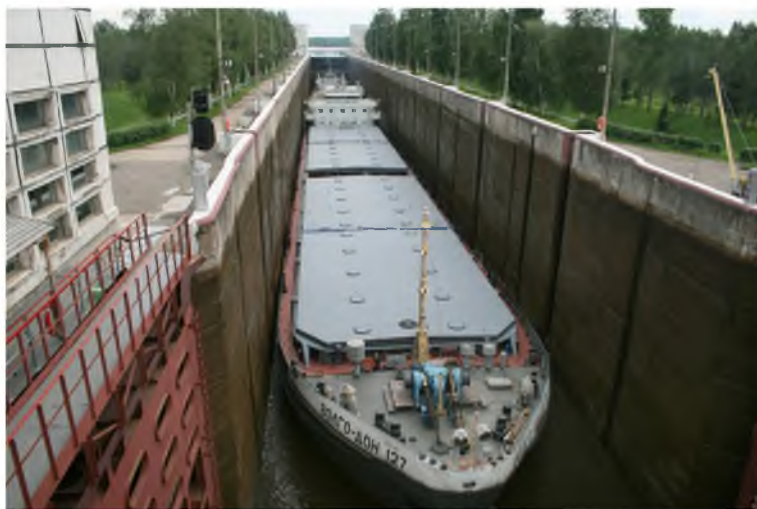
Спуск судна в шлюзовой камере
