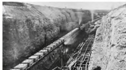
Технология выборки грунта при сооружении Девятинского перекопа
