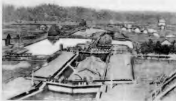
Четырехкамерный шлюз старой Мариинки. Фоторепродукция с гравюры XIX века.
