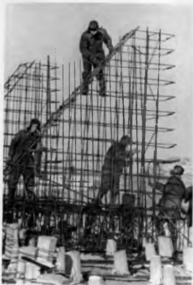
Скоро здесь будет прочная бетонная стена. Бригада И.Г. Галюченко спешит закончить монтаж арматуры.
