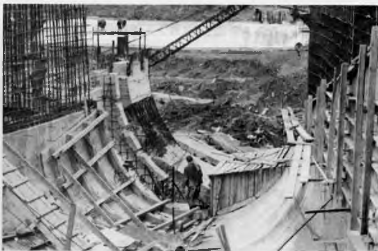
Будущее ложе турбины (отсасывающая труба) в здании Череповецкой ГЭС.
