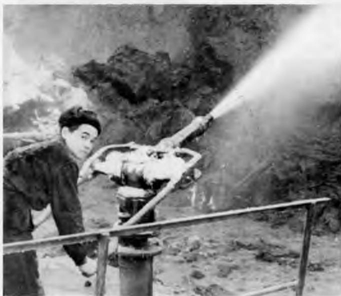
Размыв грунта гидромониторной установкой.
