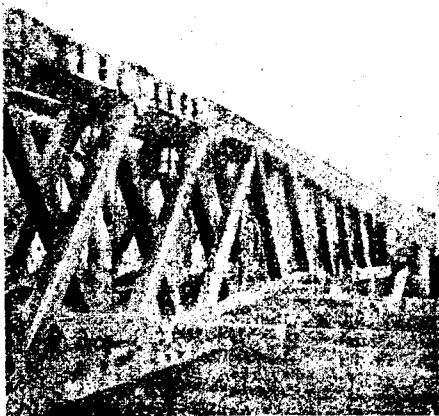
Сборка фермъ Гау съ подмостей (подъ шоссею дорогу).
