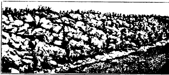
Плетневая клѣтка съ наброскою камня по откосу дамбы.
