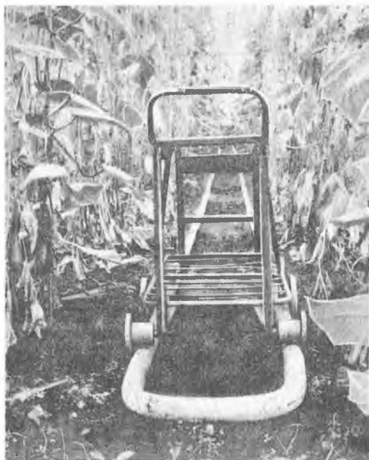
Рис. 25. Трубы надпочвенного обогрева в блочной теплице
