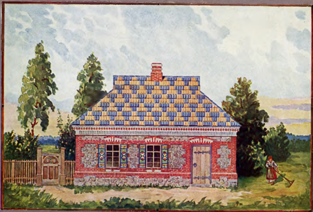
Табл. III. Фасад избы изъ булыжнаго камня съ кирпичной отдѣлкой угловъ, оконныхъ и дверныхъ проемовъ, подъ крышей изъ цементно-песчаной черепицы.
