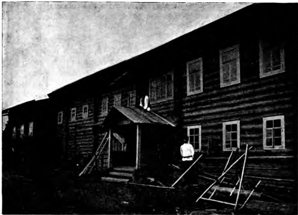
Рис. 12. Боковой фасадъ дома.
