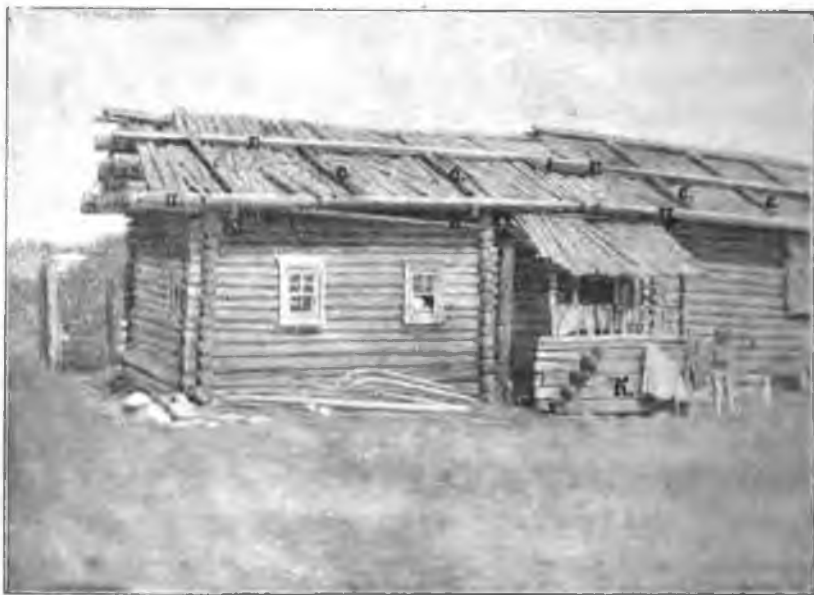
Рис. 6. Двойная изба съ сѣнями и крыльцомъ. К—крыльцо, к—кокши, и—потокъ, с—слоги, г—гнѣты.
