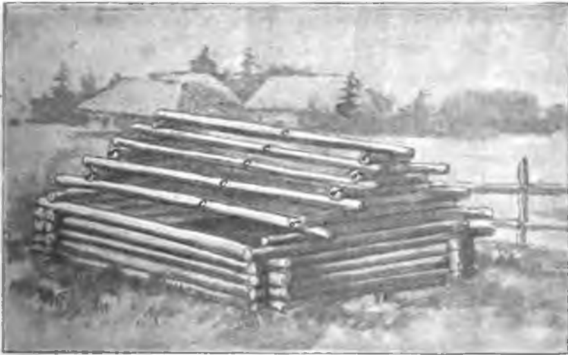
Рис. 3. Верхъ сруба съ «пасомами», с. «слеги» б. «барандыши».
