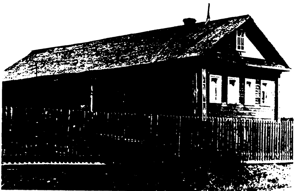
Фото 2. Дом с однорядной связью (средние вепсы, с. Немжа Подпорожского р-на Ленинградской обл.)
