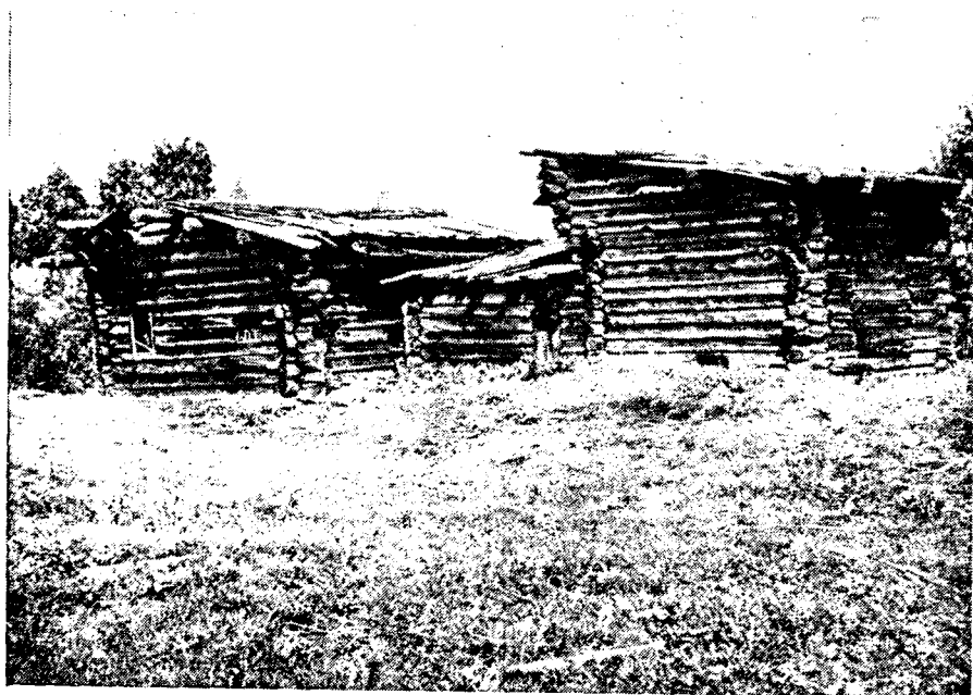
Рис. 8. Жилой дом сезонного поселения, тип III — ложнооднорядная связь жилья и двора Г-образной формы
