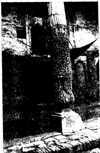
Рис. 3. Айван в медресе Мурза Баши. Колонна из вяза, высота 5,6 м, цоколь 0,4 м, капитель 0,3 м
