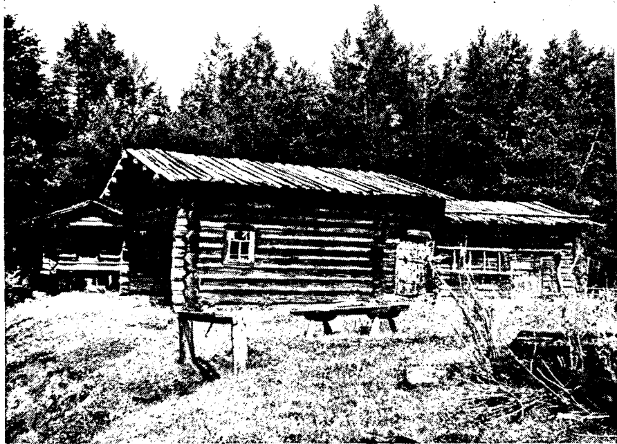
рис. 7. Жилой дом сезонного населения, тип III — ложнооднорядная связь (Улеша)
