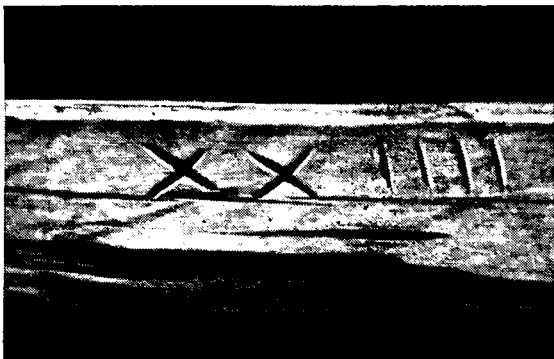
Рис. 5. Монтажный знак на стропильной «ноге» крыши Бригитского монастыря в Гродно (XVII в.)
