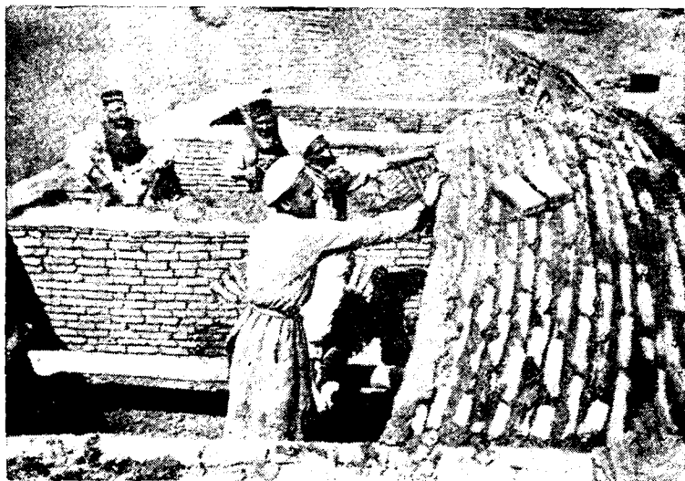
Рис. 3. Шираз. Возведение куполообразной крыши (Музей антропологии и этнографии АН СССР (МАЭ), 4146—7).
