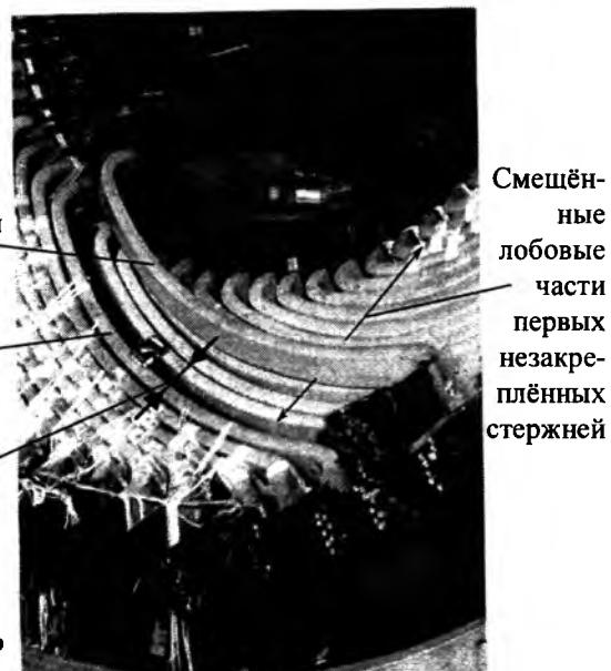
Рис.3. Исходное положение лобовой части замкового стержня со стороны возбудителя после заводки лобовой части со стороны турбины
