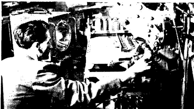
СТРОБОФЛУД „DAWE“ с контактным наконечником для исследования рабочего процесса типографской машины
