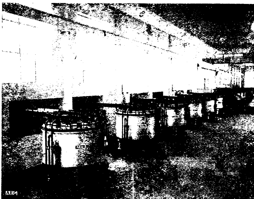
Выпрямительная установка 80 000 А состоящая из 16 выпрямителей по 5000 А 800 в для электролиза
