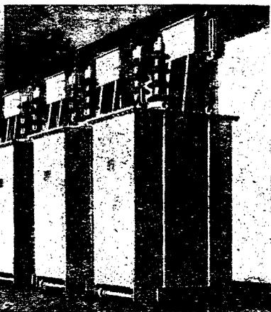
Высоковольтный конденсатор для 10/20 KV
