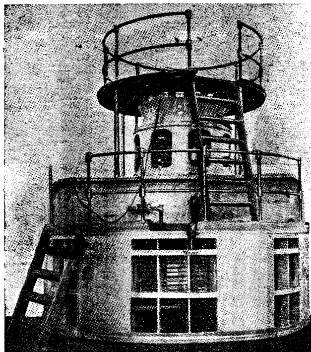
Рис. 4. Вертикальный синхронный двигатель 3500 kVA, 214 об/мин для насосов канала Волга—Москва (Харьковский электромеханический завод им. Сталина)
