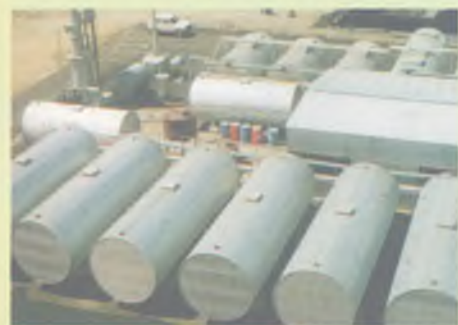
Установка для производства битумных эмульсий
