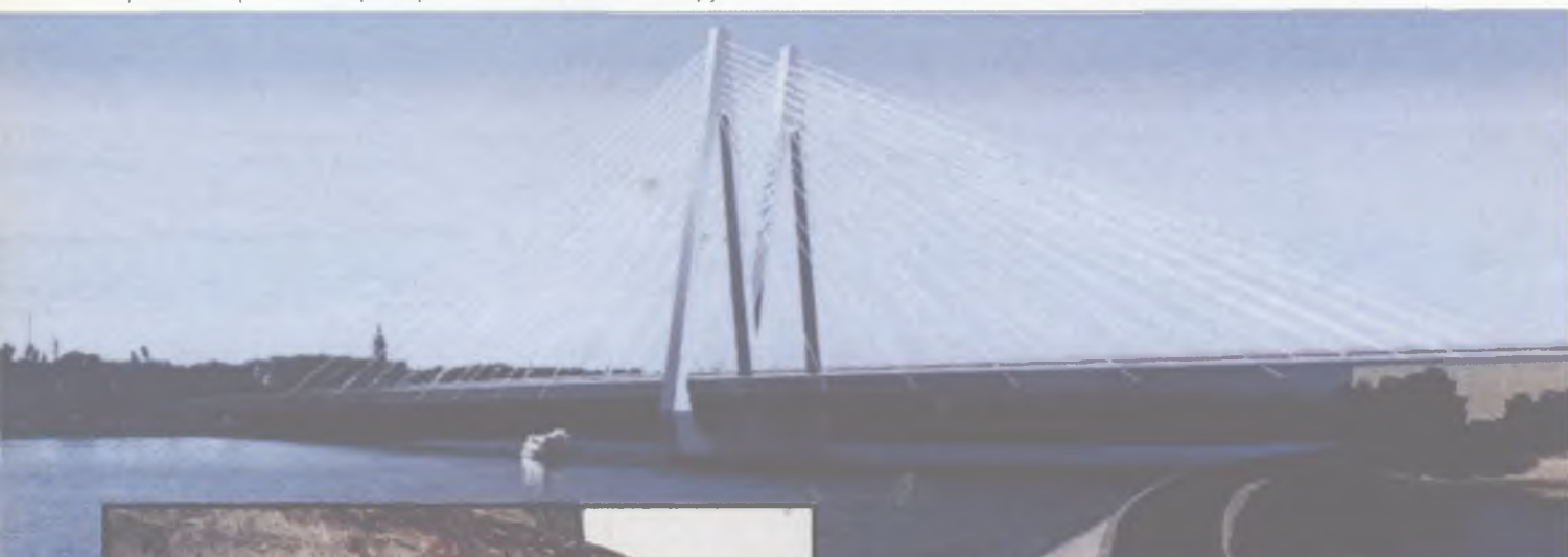
Новый вантовый мост.
