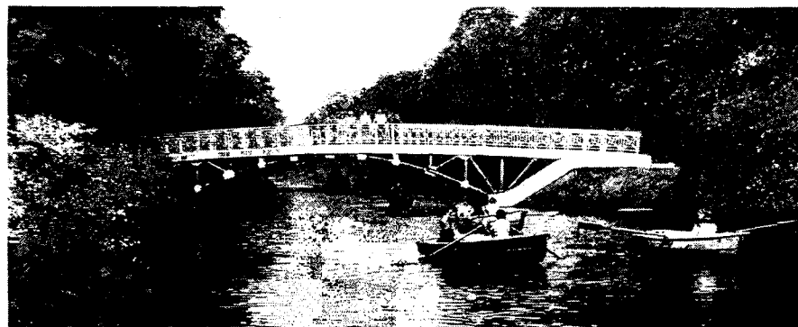
Пешеходный мост из арочных ферм в ЦПКиО имени С. М. Кирова (Санкт-Петербург)
