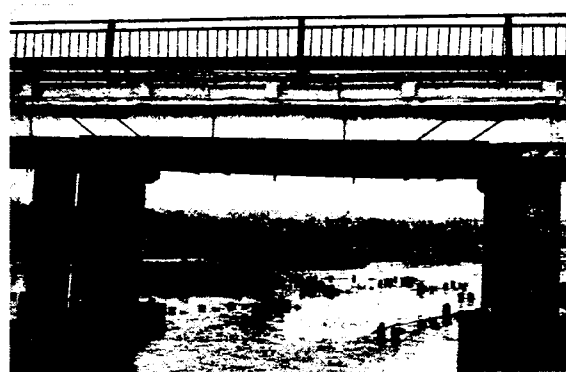
Усиление пролета наружной арматурой
