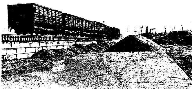
Повышенный путь на промбазе «Ливны» СУ-816 для разгрузки строительных материалов
