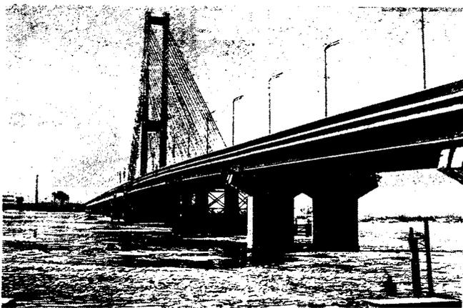
Рис. 1. Новый мост через р. Днепр в Киеве. Высота пилона 130 м
