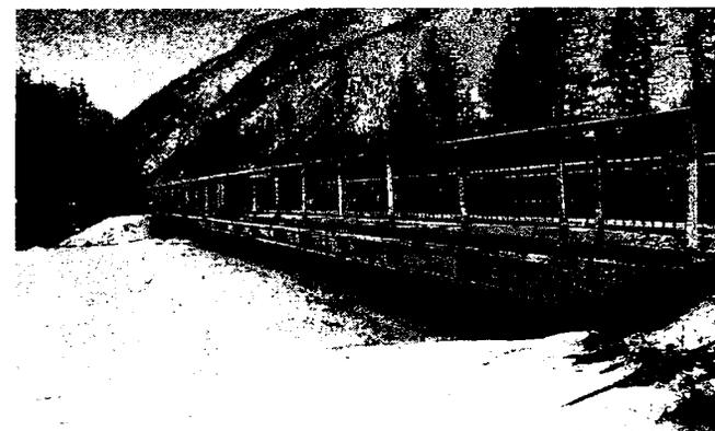
Рис. 4. Мост на 85-м км автомобильной дороги Ак-Довурак — Абаза, закупоренный наледью
