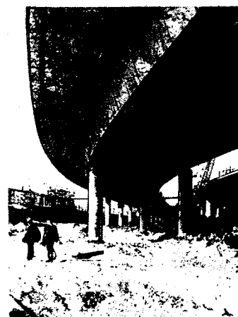
Рис. 7. Пролетное строение на криволинейном участке эстакады
