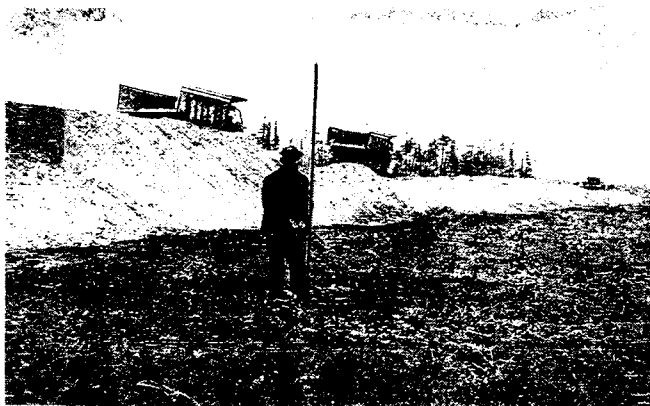
Строительство земляного полотна на болотах с применением временной пригрузки для ускорения осадки насыпи. Для контроля сроков выдерживания временной пригрузки ведется измерение осадок основания насыпи дистанционным осадкомером конструкции Белдорнии
