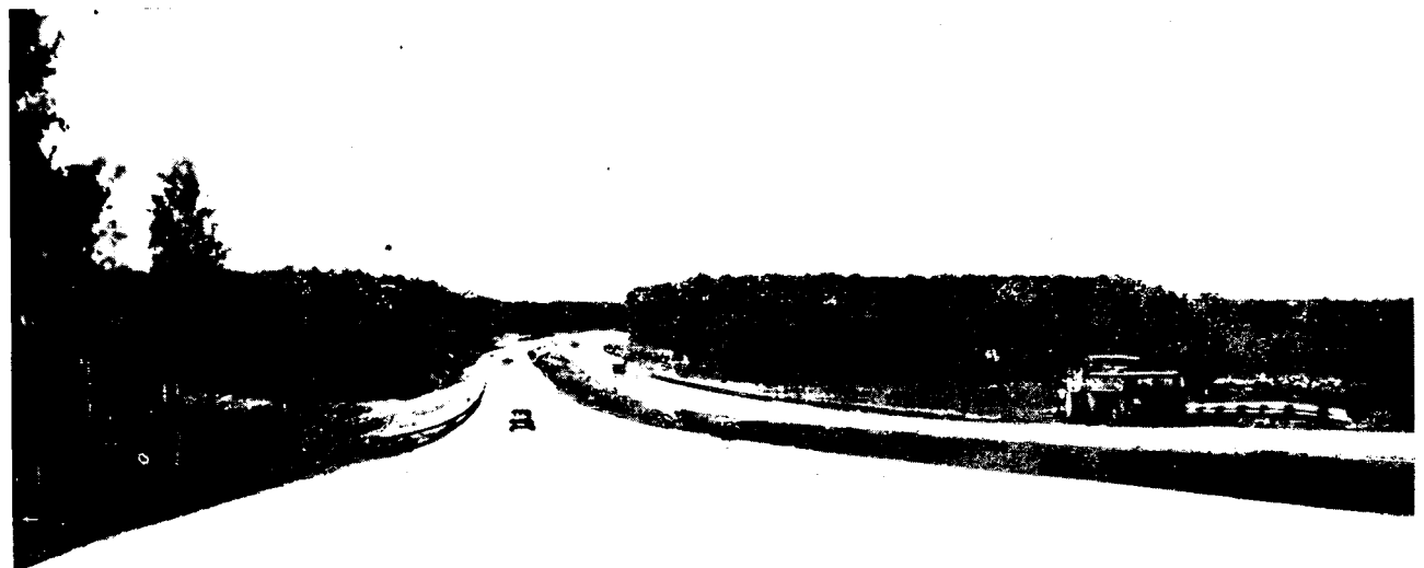
Участок дороги (км 117—119), запроектированный с клотоидными кривыми в плане
