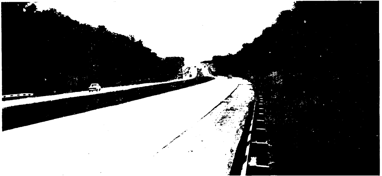
Участок дороги (км 117—119), запроектированный с клотоидными кривыми в плане
