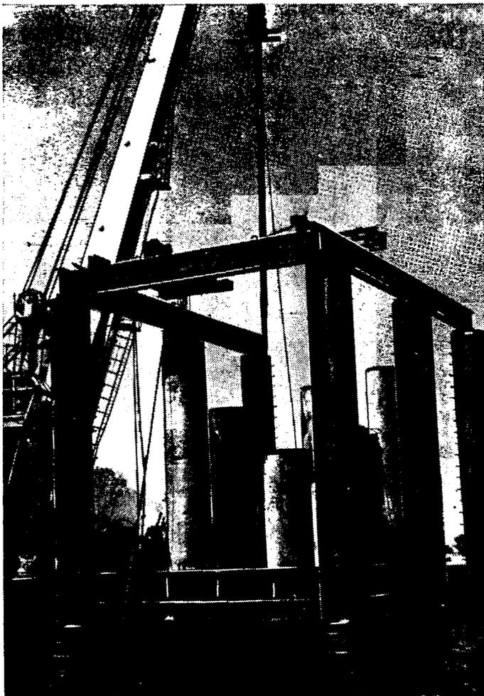
Рис. 2. Монтаж опор моста
