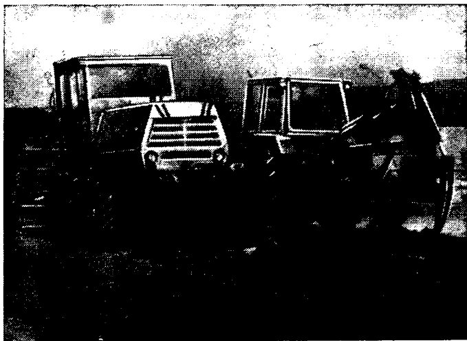
Рис. 1. Удаление старого асфальтобетонного покрытия
