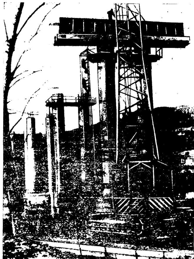
Возведение промежуточных опор моста-эстакады
