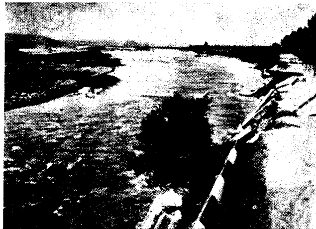
Рис. 1. Разрушение земляного полотна автомобильной дороги Ивано-Франковск — Быстрица, расположенной вдоль р. Быстрица-Надворнянская, паводком 1969 г.
