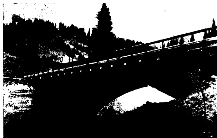
Арочный мост на дороге к лыжно-спортивной базе Чимбулак. Пролетное строение состоит из двух сводов с жесткой арматурой из металлических труб (автор Бостанжиев К. Р.)
