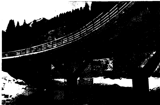
Трехпролетный односекционный рамный мост, расположенный в плане на кривой с радиусом 100 м на дороге к спортивному комплексу «Медео» (автор Кобенко А. А.)
