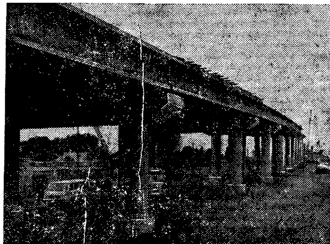
Строительство моста в дельте р. Волги. Схема моста 11 \times 21+63+84+63+3 \times 21 м, Г 10+2 \times 1,5
