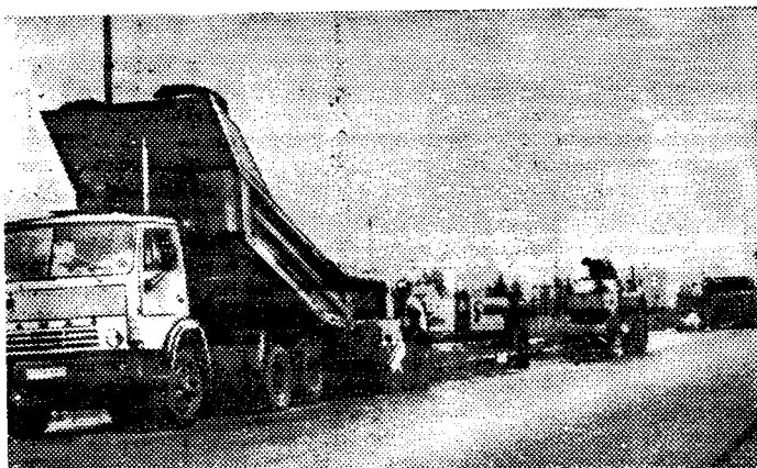
На строительстве дороги к городу энергетиков Чернобыльской АЭС — Славутичу
