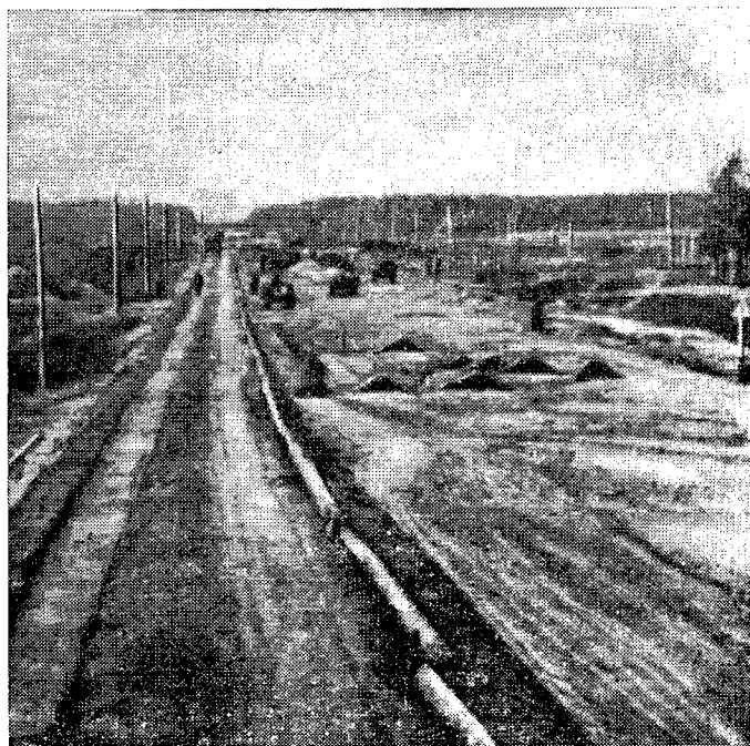
Движение открыто по деревянной колейной дороге, уложенной на обочине разрушенного участка автомагистрали Москва — Минск
