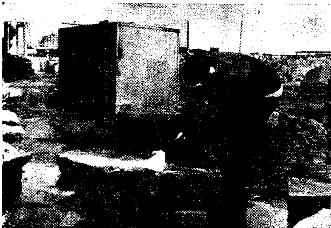
Обработка камня ручными термическими инструментами
