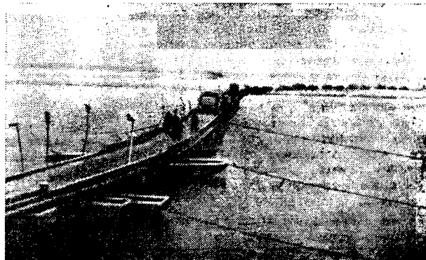
Низководный мост с разводными пролетами, построенный через р. Днепр дорожными частями генерал-майора техн. войск К. Т. Донеца
