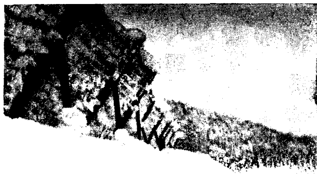
Рис. 3. Сетчатые снегоудерживающие устройства на лавиноопасном склоне
