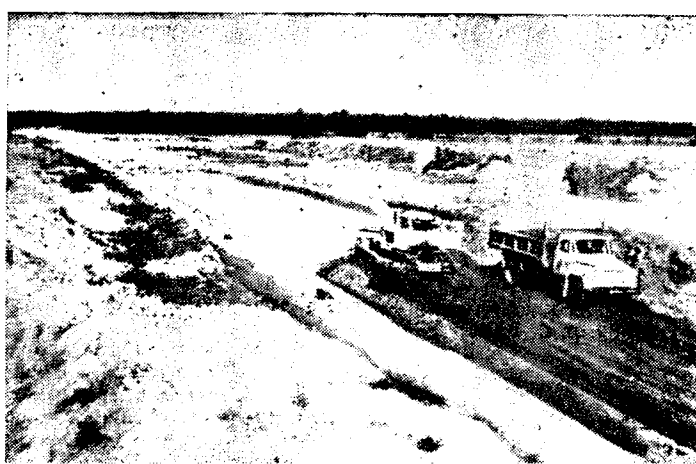
Рис. 5. Устройство прослойки из нетканого синтетического материала
