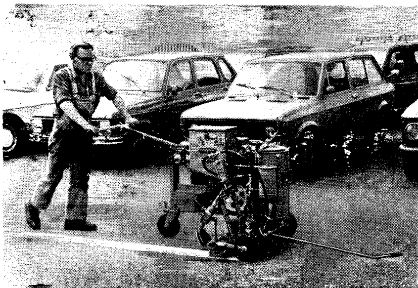
Ручная разметочная машина «Н-92» в работе (фирма «Хофманн», ФРГ)
