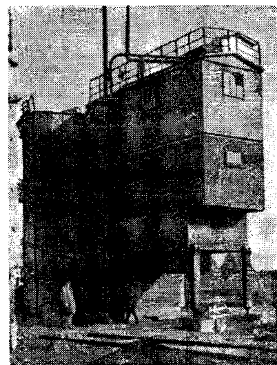
Рис. 4. Автоматизированная бетоно-смесительная установка — АБСУ-15
