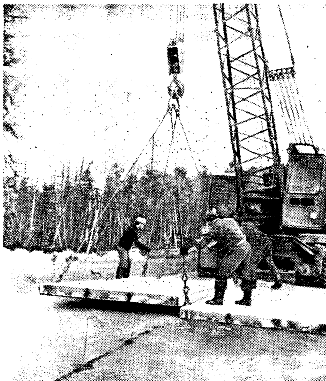
Монтаж бетонных плит на синтетической прослойке
