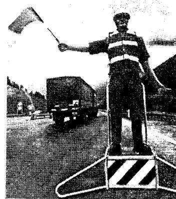
Робот-манекен, указывающий водителями флажка направление объезда ремонтируемого участка дороги
